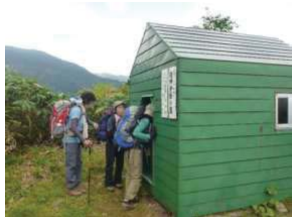
白樺避難小屋を見学
