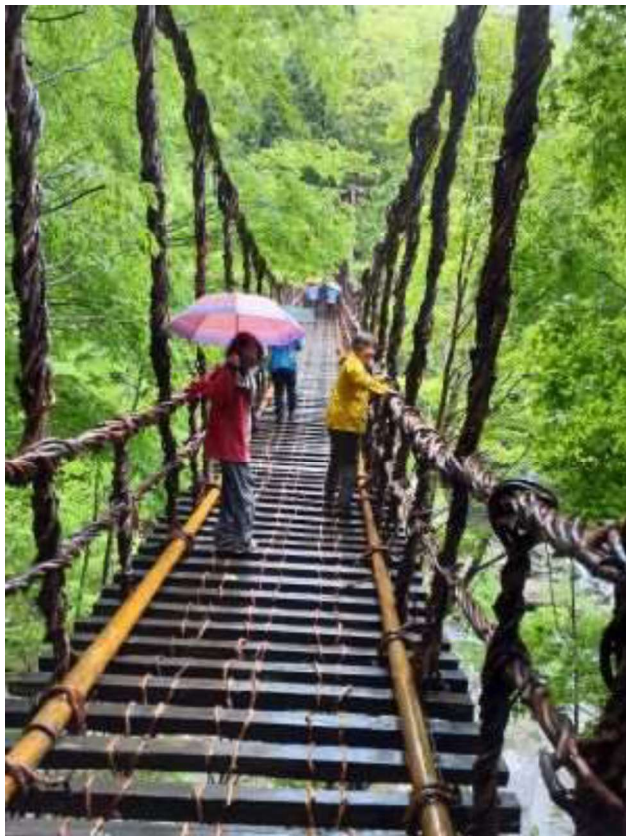
奥祖谷二重かずら橋 男橋
