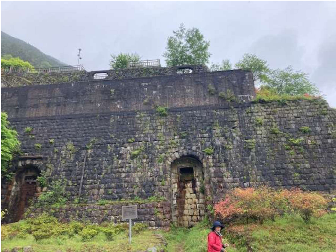
東平 3段の索道場。最上段が貯鉱庫、上段が選鉱された鉱石の貯鉱庫、下段が索道基地。
